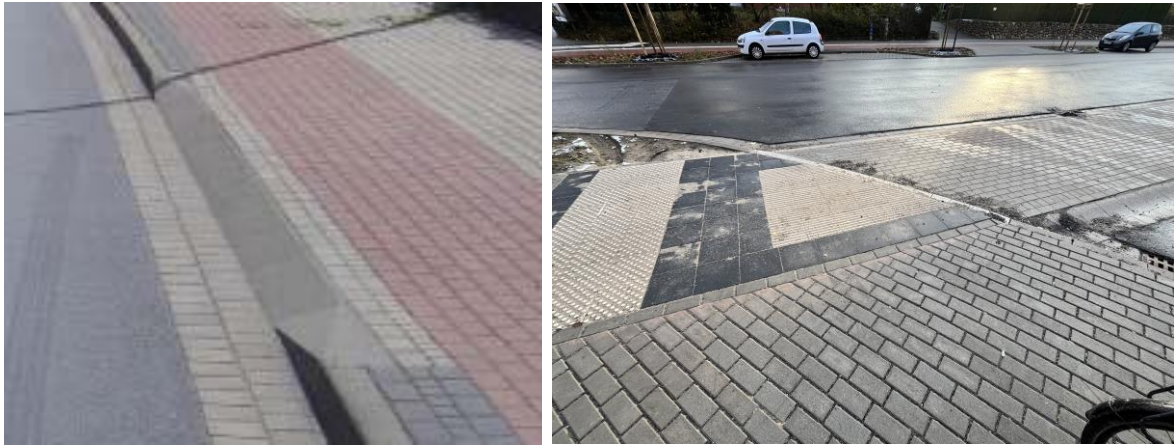
Abb: Gehwegüberfahrt mit Rampenstein bei Grundstücksausfahrt und Wohnstraße
