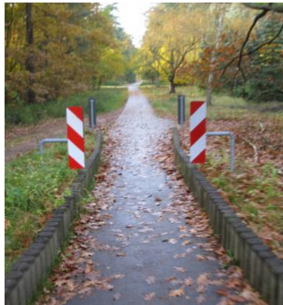
Abb.: Barrierefreier Ausschluss von Kfz durch bauliche Verengung (Quelle: ADFC)
