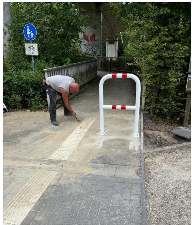
Abb.: Barrierefreier Umbau mit Sperrelement, Aufmerksamkeitsfeld, Leitstreifen (RVF 3.0)
