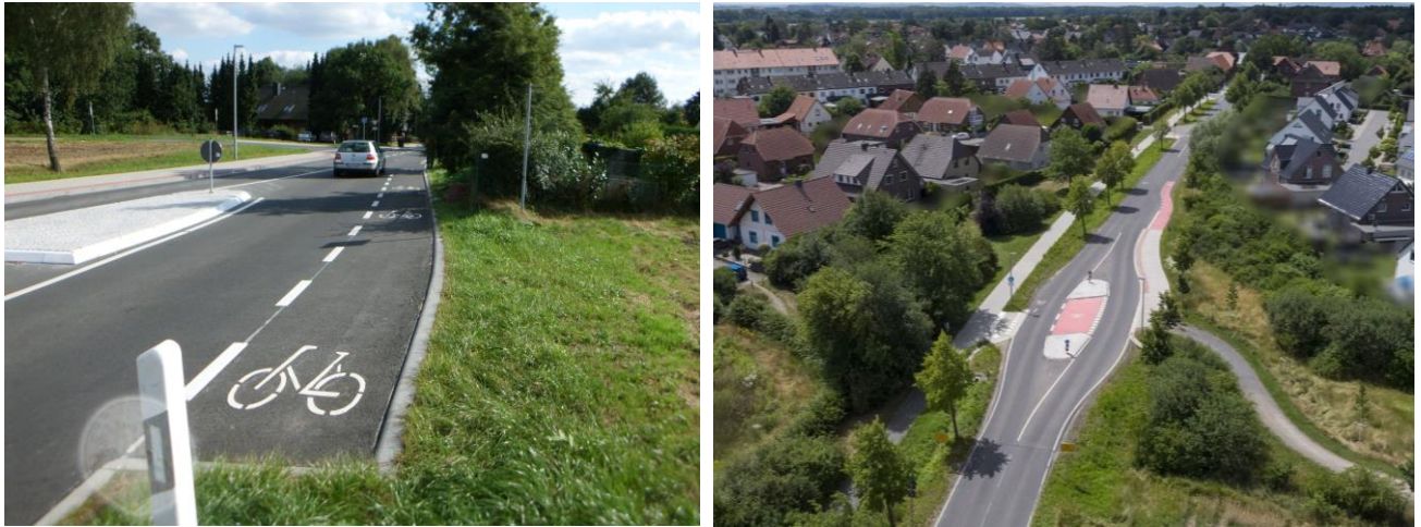
Abb. 2: Aufleitung mit Querungshilfe und kurzem Schutzstreifen, Bild: Reg. Hannover, Claus Kirsch
