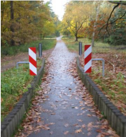
Abb: Barrierefreier Ausschluss von Kfz durch bauliche Verengung (Quelle: ADFC)
