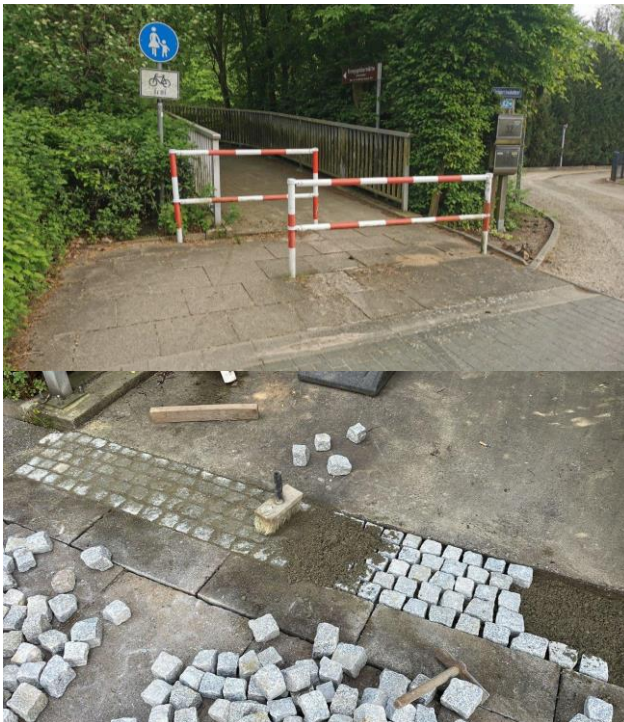
Abb.: Barrierefreier Umbau mit Sperrelement, Aufmerksamkeitsfeld, Leitstreifen (RVF 3.0)
