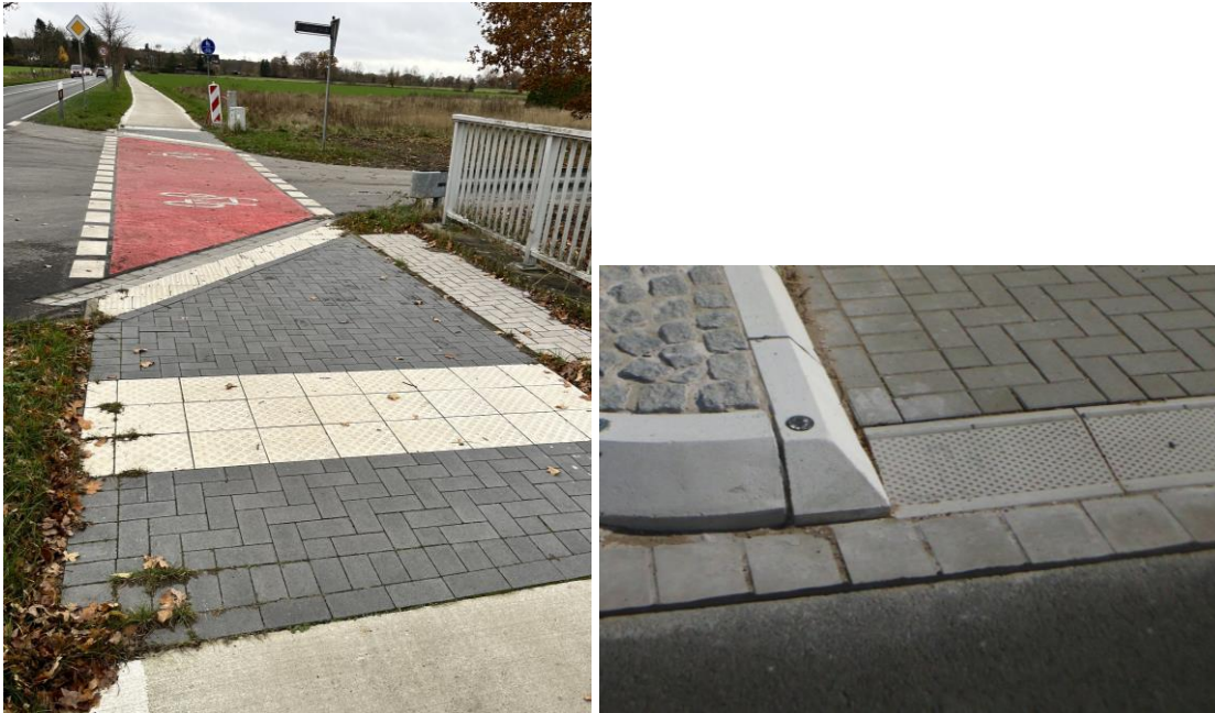
Abb.: Querung außerorts mit abgesetztem Aufmerksamkeitsfeld, Richtungsfeld, Rinne und Farbwechsel der Beläge, Detail: Rampenstein (ohne Richtungsfeld)
