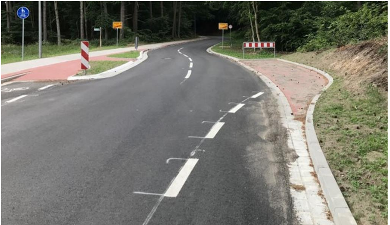
Abb. 1: Aufleitung ohne Querungshilfe mit Aufstellbereich, Geschütztes Radwegende mit Führung in den Mischverkehr
