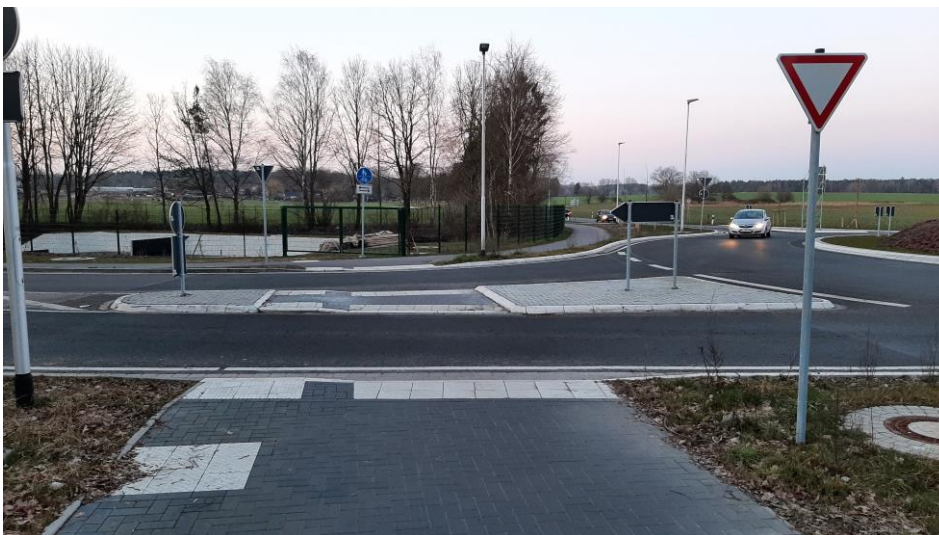
Abb.: Querung außerorts mit differenzierter Bordhöhe, breiter Radfurt mit Sperrfeld, Fußverkehrsquerung mit unterbrochenem Auffindestreifen vor dem Richtungsfeld
