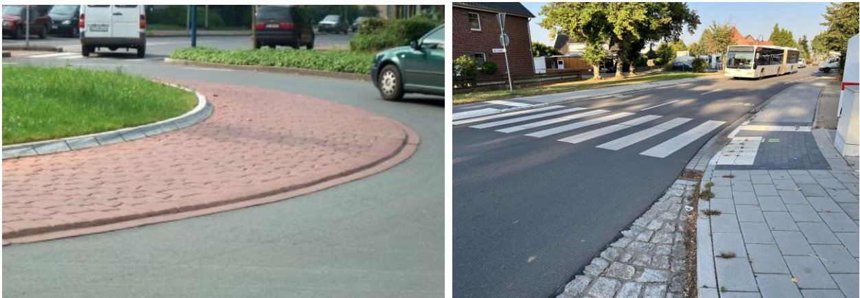
Abb.: Innenring farblich, Betonfertigelement, H 4-5 cm, Querung am Minikreisel mit aufgelösten Schutzstreifen
